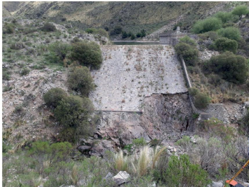
Figura 3. Vista de la rotura de la rápida del vertedero lateral del Dique Los Alazanes.
